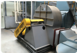
9 연소공기송풍기 (Combustion Air Ventilator)
