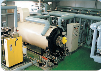
횡형 열매체보일러 Horizontal Type Thermal Boiler
