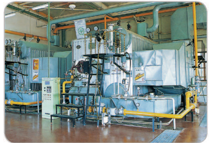
수관식 증기보일러 Water Tube Steam Boiler
