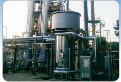
입형 열매체보일러 Vertical Thermal Boiler
