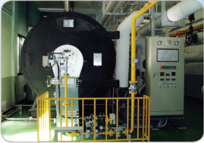
공기에열기 내장형 고효율 열매체보일러 Air Preheater Built-in High Efficiency and Thermal Boiler
